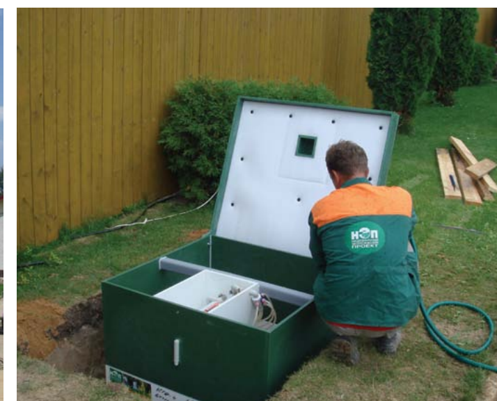
Пуско-наладочные работы установленной станции
