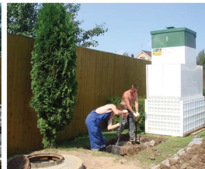
Раскопка земляной выемки производится вручную с минимальными нарушениями ландшафта
