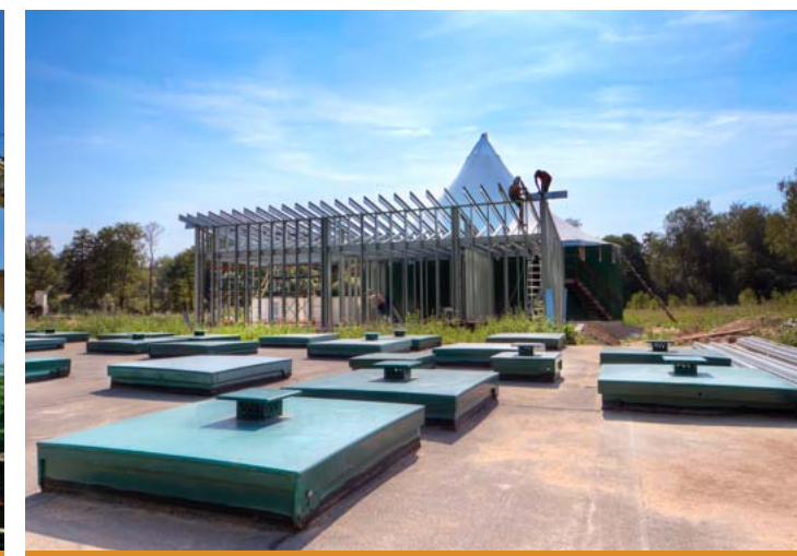
Завершение строительства очистных сооружений
