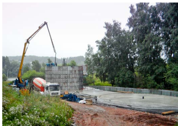
Заливка первого резервуара
