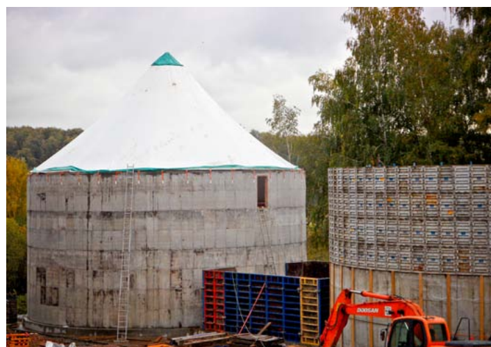
Установка крыши шатрового типа
