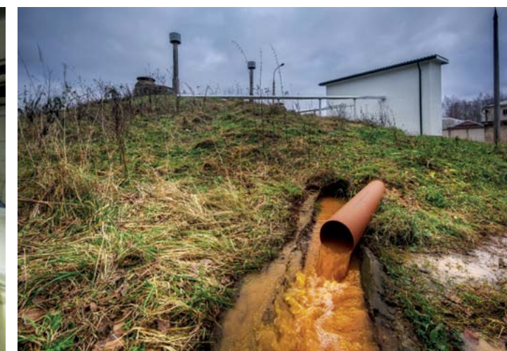
Отвод концентрата при самопромывке
