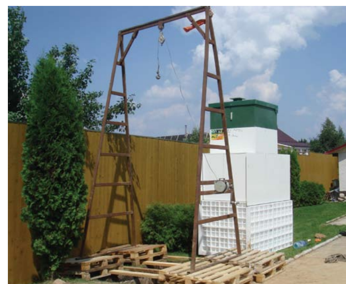
Монтаж станции ЮБАС в земляную выемку
