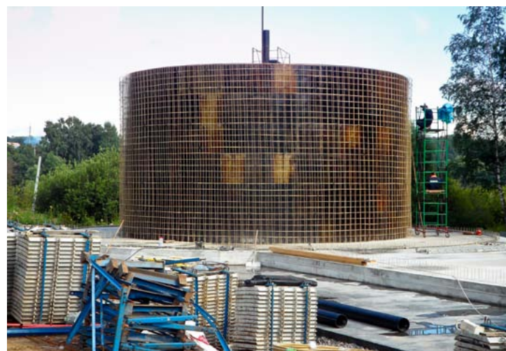
Сборка опалубки
