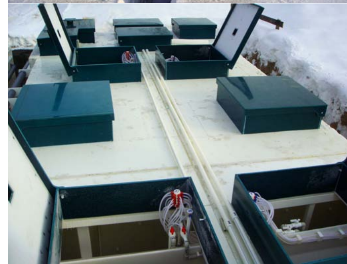
Завершение монтажа "ЕВРОБИОН-БИОМАТРИКС"
