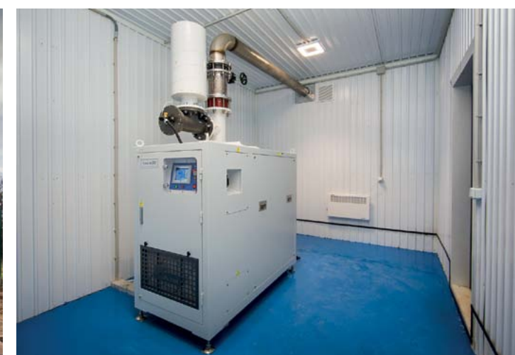
Компрессорная с импеллерной воздуходувкой "Нейрус"
