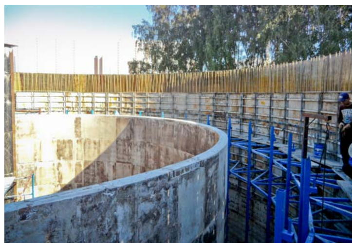
Формирование кольцевого аэротенка зональной аэрации
