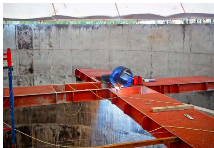
Монтаж эксплуатационных проходов
