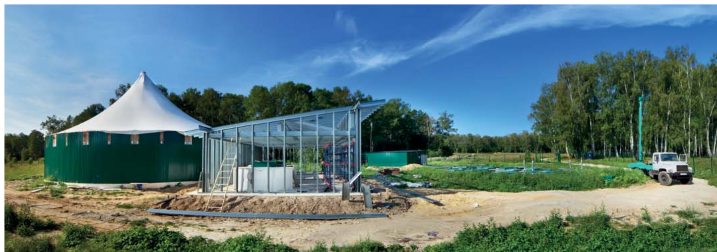
Строительство ЕВРОБИОН-ГРАНД -750м 3 в экопоселке «Новое Ступино»
